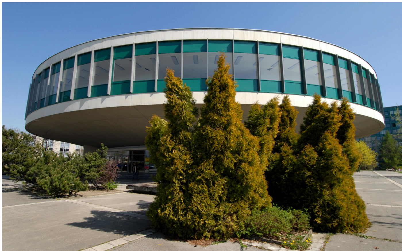
3 * BUDOVA C - POSLUCHÁRNÝ
