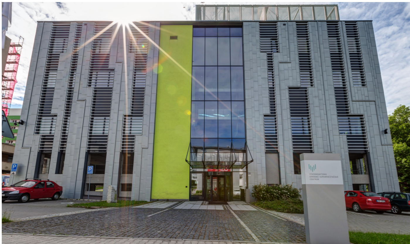
11 * HLAVNÍ VSTUP IT4I
