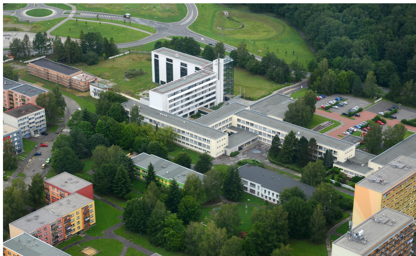
23 * AREAL FAKULTY STAVEBNÍ (FAST)
