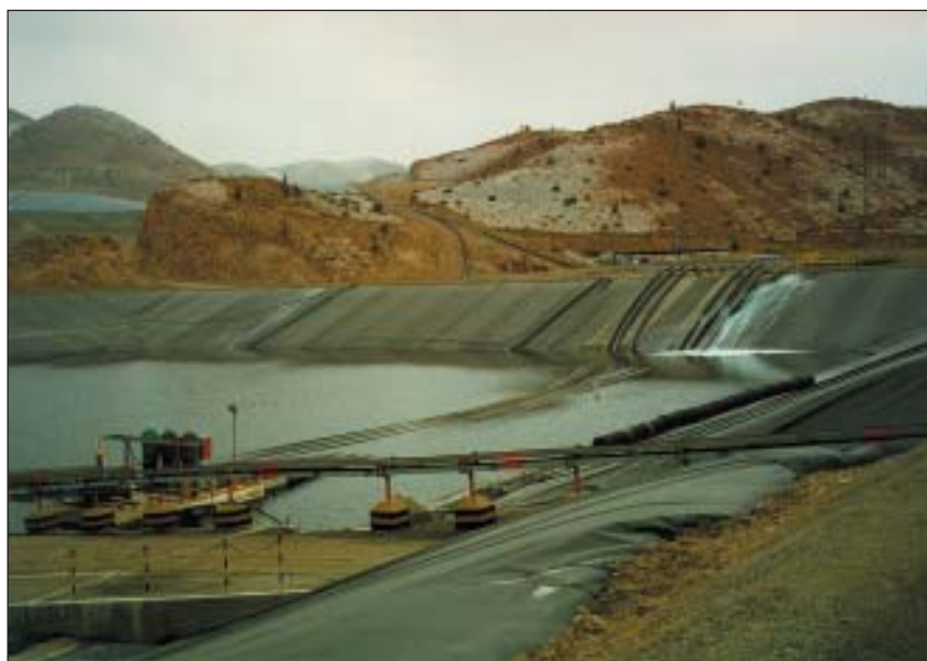
Sběrná nádrž mědinosných roztoků z hydrometalurgického zpracování rud v Cerro Verde u Arequipy
