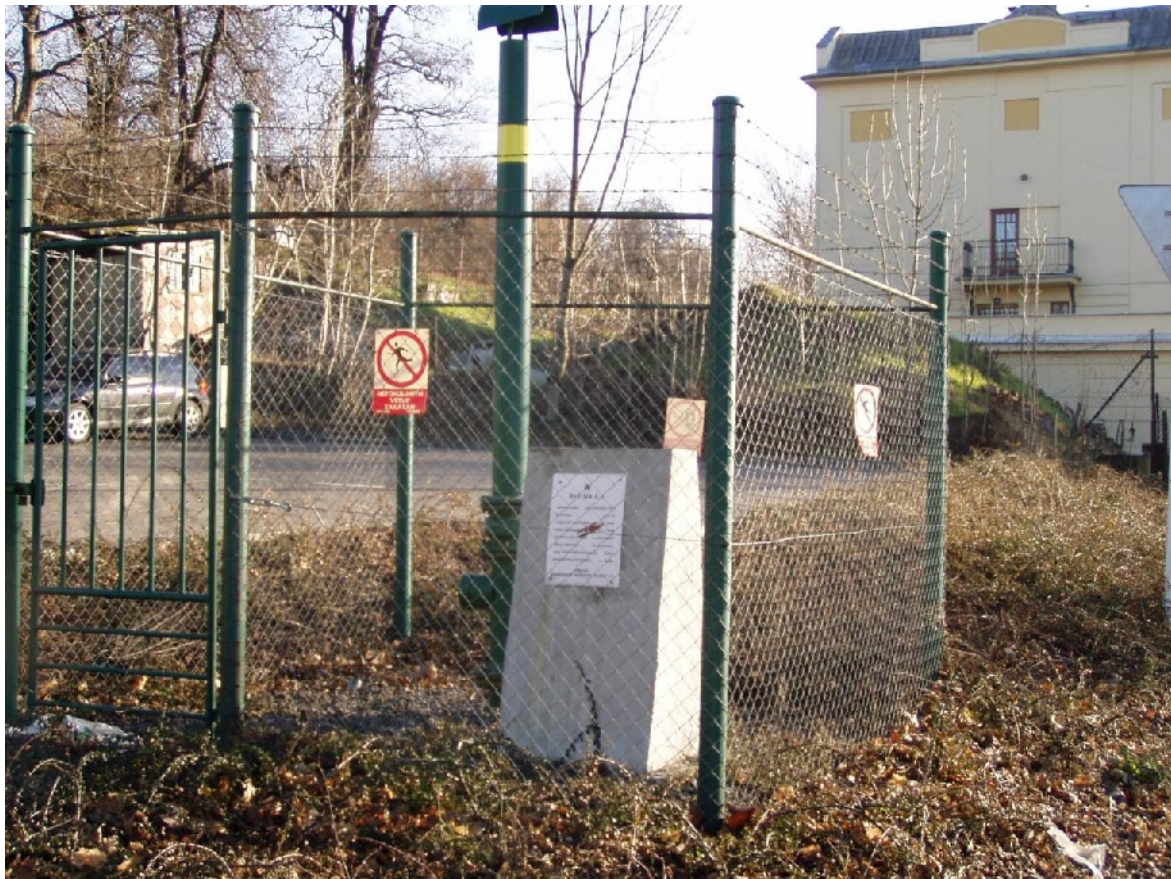
Obrázek 4: Světlík č.4 na Zámostní ulici, Slezská Ostrava
