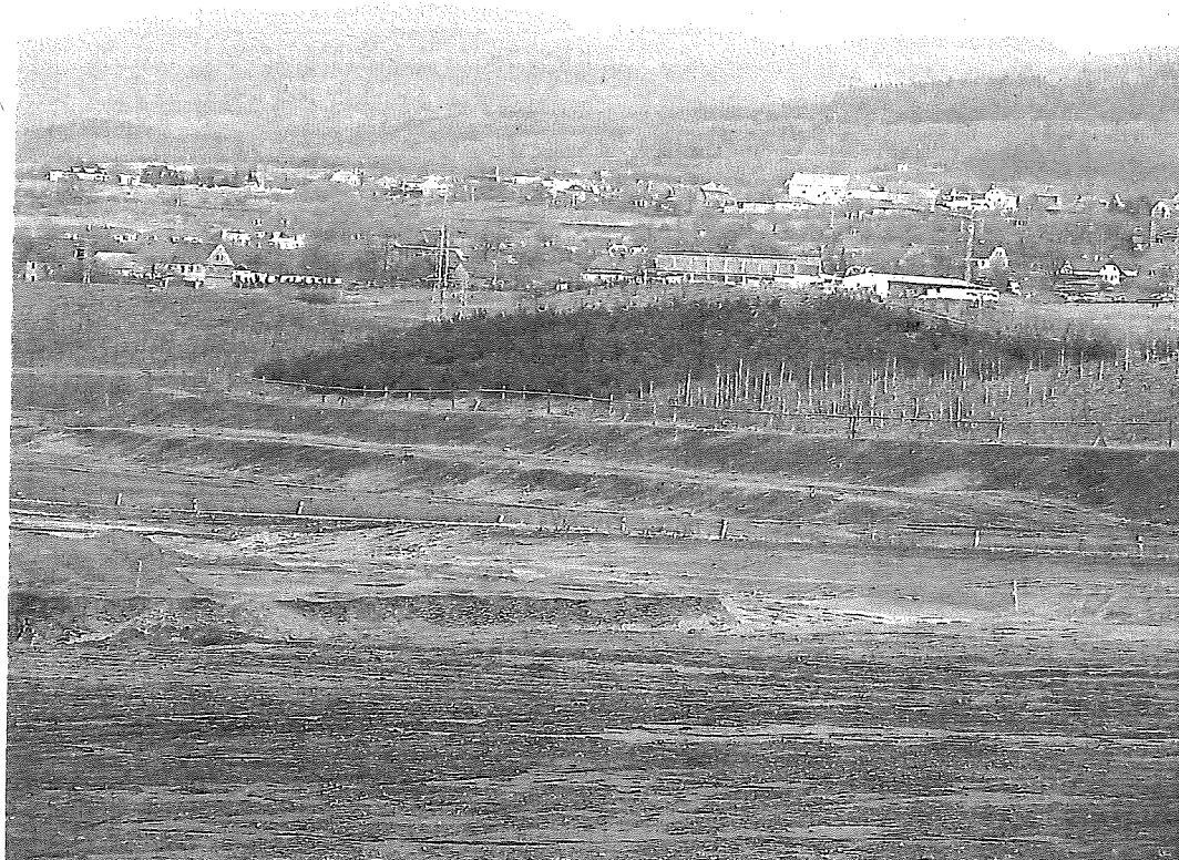
Obr. 7.4 Ochranné zemní valy u obce Černovice (severní Čechy) [8]
