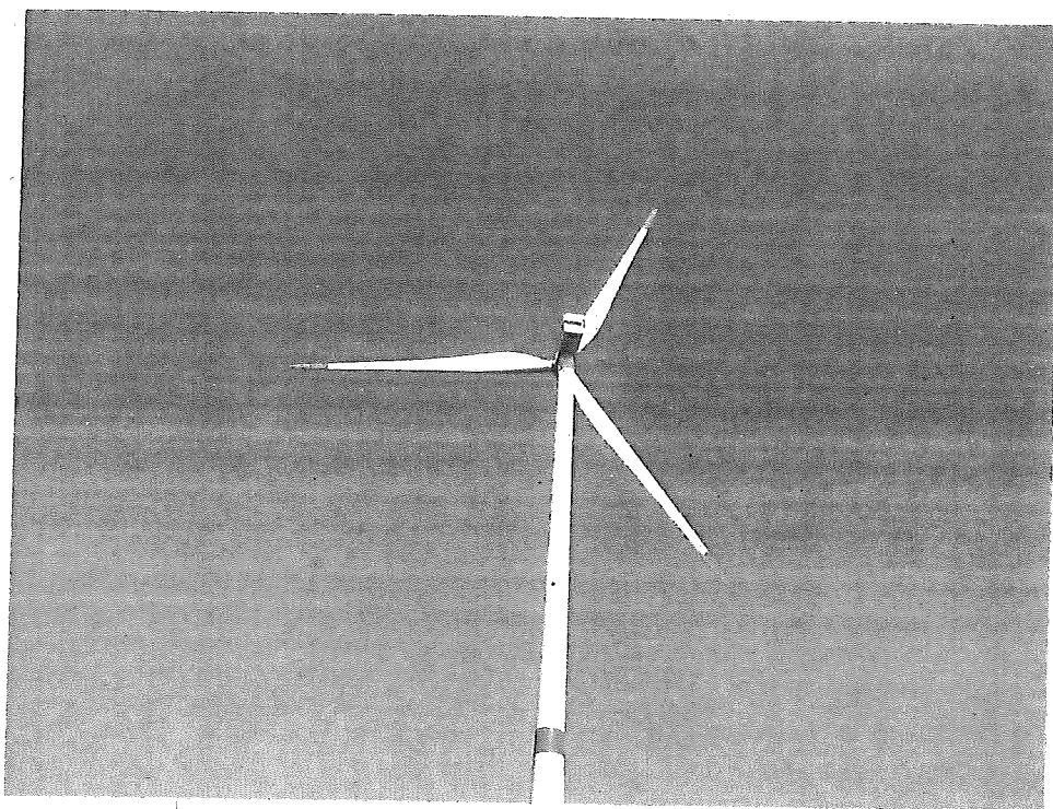
Obr. 8.29 Pohled na rotor, gondolu a horní část stožáru větrné elektrárny Vestas
