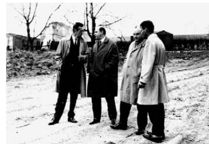
Prorektor Kittrich (vlevo) na stavbě areálu VŠB v Porubě 1962 (archiv VŠB-TUO) / Vice Rector Kittrich (on the left) at the VŠB campus construction site in Poruba, 1962 (VŠB-TUO archive)
