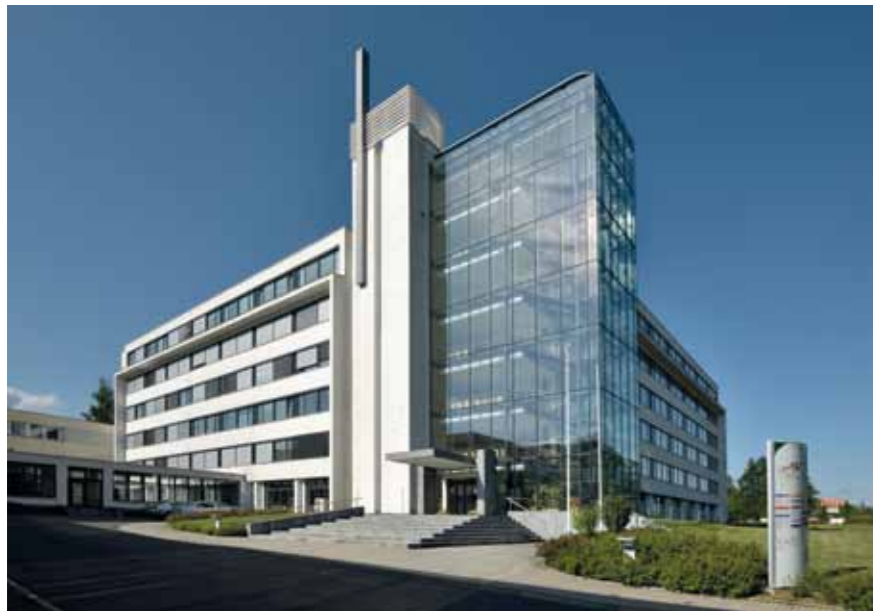
Fakulta stavební – dostavba pavilonu velkých poslucháren 2007–2009 (foto Roman Polášek, 2017) / Civil Engineering Faculty – completion of the construction of the pavilion with large auditoriums 2007-2009 (photo Roman Polášek, 2017)
