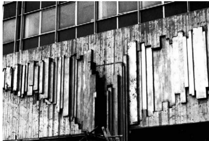
Instalace Gajdova reliéfu (stavební archiv VŠB-TUO) / Installation of Gajda's relief (VŠB-TUO building archive)
