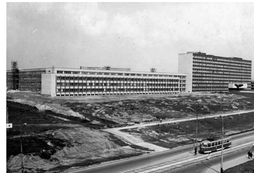
Budovy VŠB v 70. letech – pohled z tehdejší třídy Vítězného února, dnes 17. listopadu (archiv VŠB-TUO) / The VŠB buildings in the 1970's – A View from Vítězného února St. (today's 17. listopadu) (VŠB-TUO archive)
