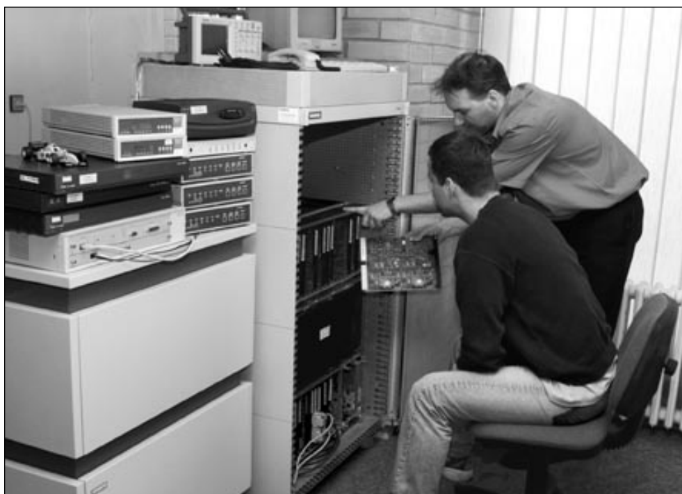
Z práce na telefonní ústředně
