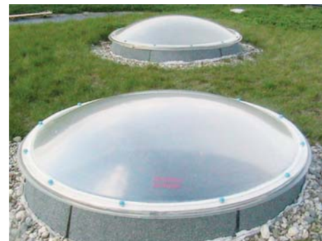
Foto 4: světlovod do kuchyně Centra ekologických aktivit Sluňákov
